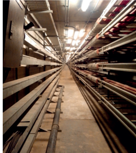
รูปที่ 1 ลักษณะทางเข้าออกและพื้นที่ภายในอุโมงค์ไฟฟ้าแรงดันสูง
