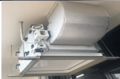
รูปแสดงตู้ระบายอากาศ (EXHAUST FAN) และการติดตั้งตู้ระบายอากาศสำหรับห้องทันตกรรมแบบปิด
